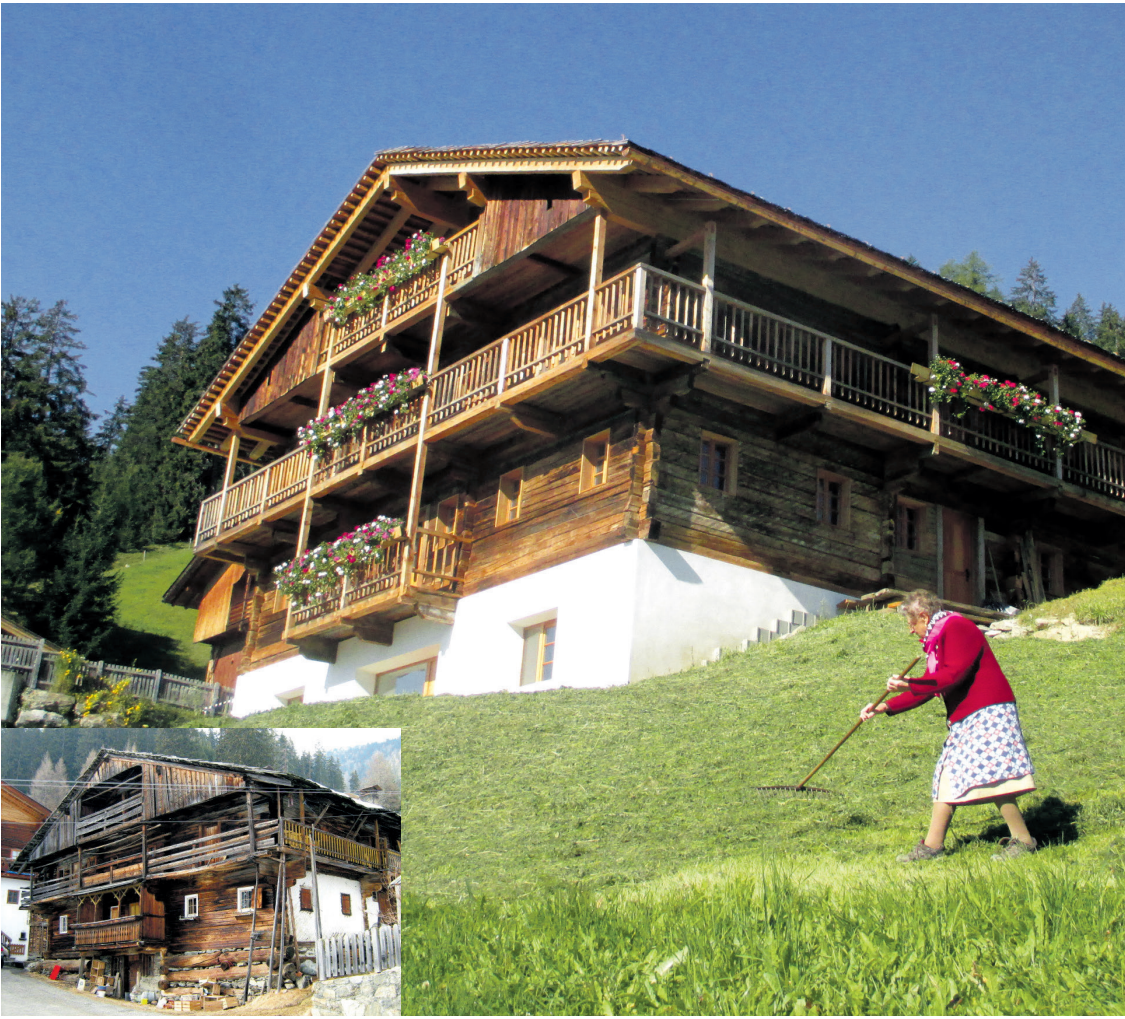
Der Veidlerhof im alten Zustand (kleines Bild) und heute, in 100 Meter Entfernung neu aufgebaut.
